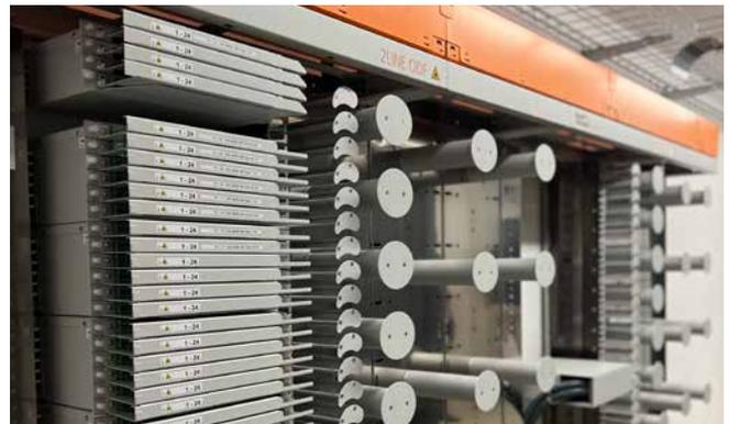
Die Mikrorohre wurden mit individuellen Ringraumdichtungen der Firma Hauff-Technik in den Kellerraum eingeführt, welche eine saubere, wasser- und gasdichte Wanddurchführung herstellen. Für die wasser- und gasdichte Einführung der Mikrorohre beim Endkunden wurde die Mauerdurchführung GFH20 verwendet. Zur Aufnahme und Beschaltung mit optischen Signalen der Glasfaser, wurde das ZLINE ODF-System von der Firma Hauff-Technik GRIDCOM eingesetzt.
