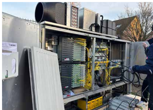
Anschluss aktives Kühlsystem
